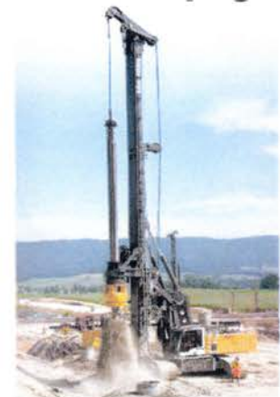
FORAGES DE FONDATIONS CONSTRUCTIONS
